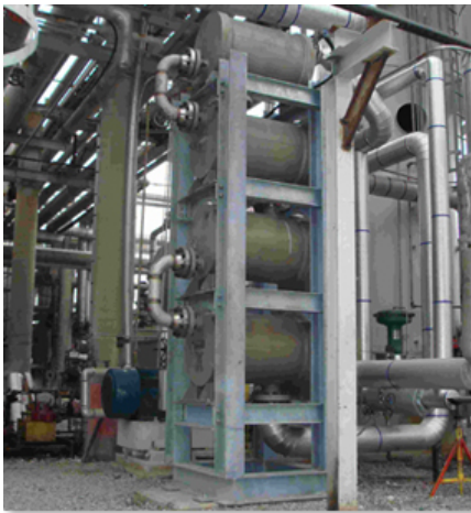
Для увеличения длины теплообмена отдельные теплообменники могут быть объединены. Показаны экономайзеры конденсата аммиачного десорбера на заводе по производству удобрений.
