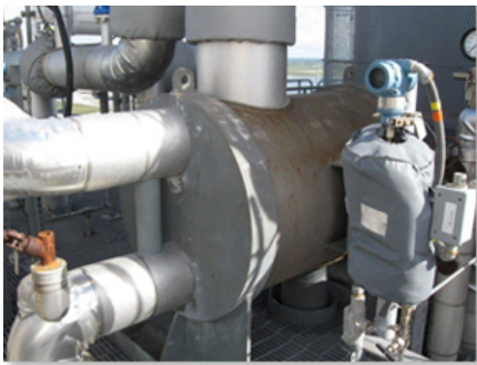
Этот блок при температуре 900°C и давлении 103 бар изб. (1650°F и 1500 фунт/кв. дюйм изб.), используется в нагревателе конденсата питательной воды на электростанциях.
