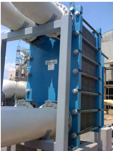
Эти пластинчатые теплообменники Tranter установлены на электростанции смешанного цикла, работающей на природном газе в США в качестве эффективного средства охлаждения.
